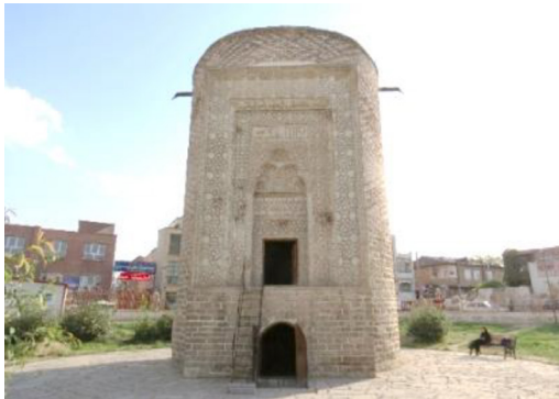
تصویر ۱۵. نمای کلی سه گنبد ارومیه
