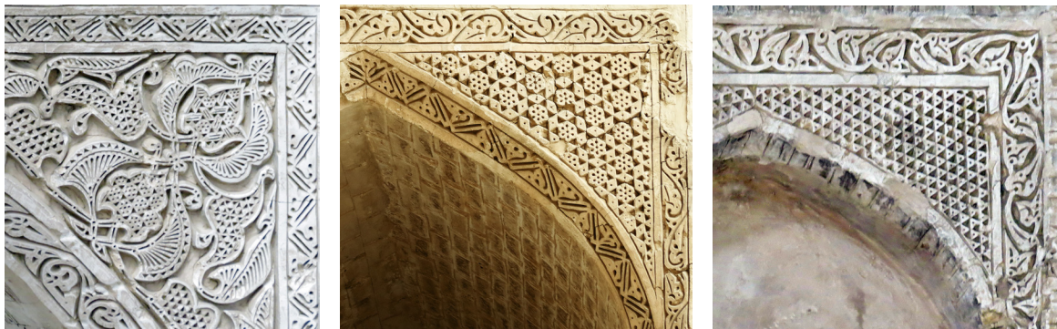
تصویر ۱۱. کاربرد تزئینات آژده کاری در لچکی‌ها و بر روی سطوح نقش‌مایه‌های اسلیمی در گچ‌بری‌های مسجد جامع ورامین.
